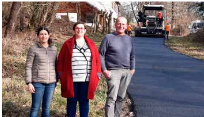
LA ROUTISSE : pose d'enrobé
