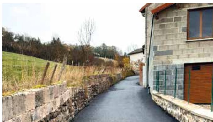
CHEMIN DES ÉCHELLES : réseaux + enrobé
