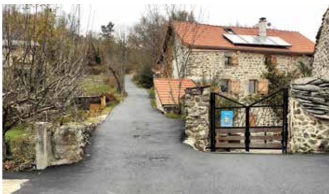
BLANLHAC - Chemin des Grillés : pose d'enrobé
