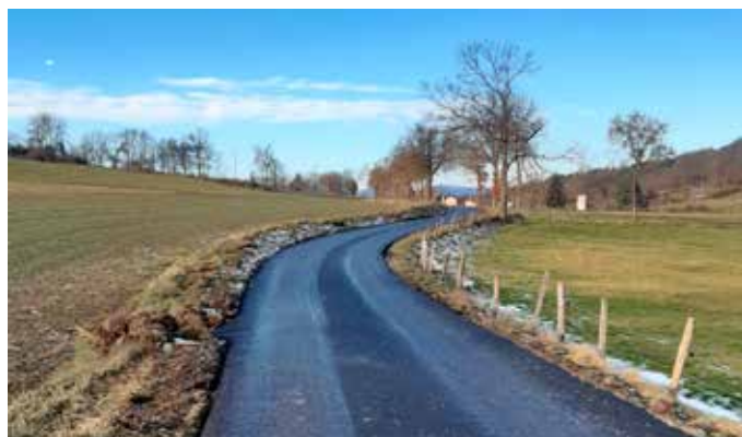
LE GARAY- COINDET : pose d'enrobé
